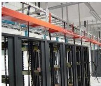
图 2-43 数据中心桥架施工走线图
