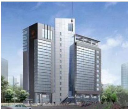
图 2-1 铁路调度中心大楼
